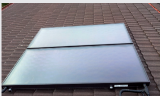
I PANNELLI SOLARI termici Viessmann Vitosol 200 F superficie 4.6 mq.
