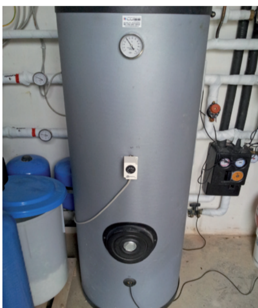
IL BOLLITORE sanitario Viessmann Solarmax da 300 litri bivalente.
