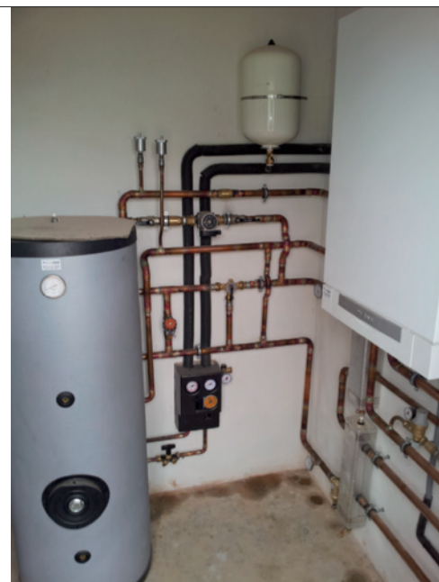
REGOLAZIONE per gestione impianto solare; completamento esterno.
